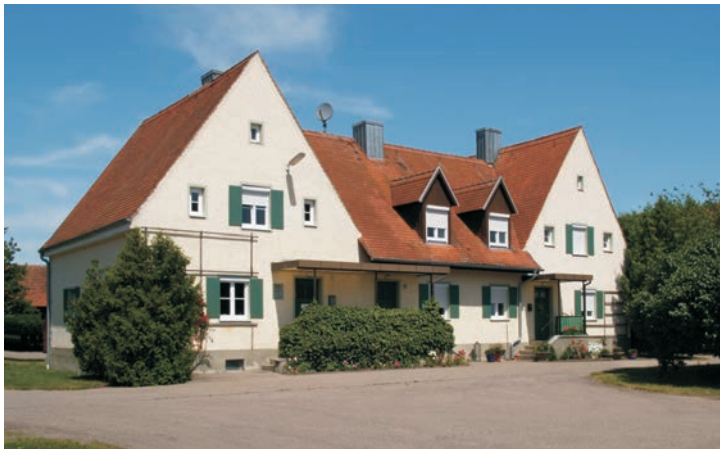
Verwaltungsgebäude des Baumannshofs
